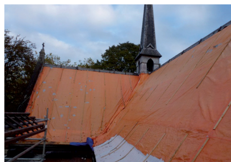
Kerkdak onder de afdekzeilen
